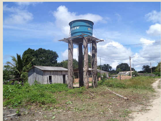
Reservatório de água na comunidade
