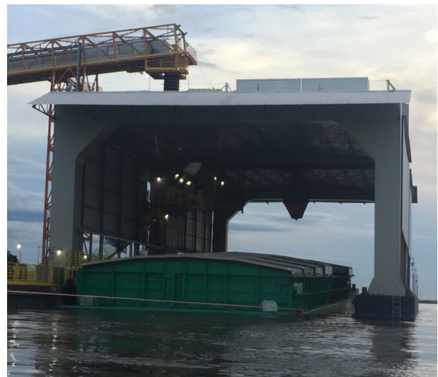
Exemplo de Ancoragem do carregador de barcaças com uso de pinos deslizantes
