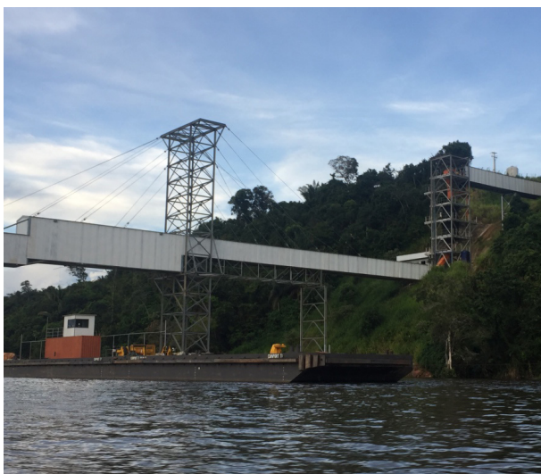
Exemplo de Ancoragem do carregador de barcaças com uso de poitas.
