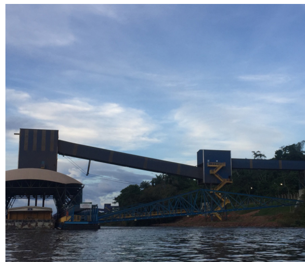
Exemplo de Ancoragem do carregador de barcaças com uso de espias
