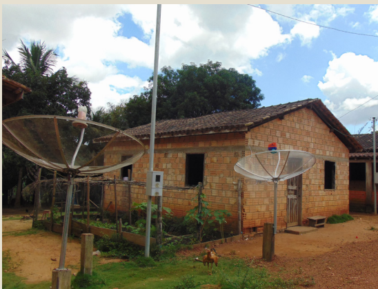
Casas de alvenaria com antenas parabólicas também existentes na AID
