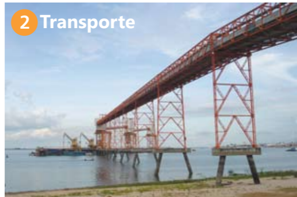
A soja segue do píer ao Terminal em correias enclausuradas para controle de poeiras e é pesada em balança de fluxo.
