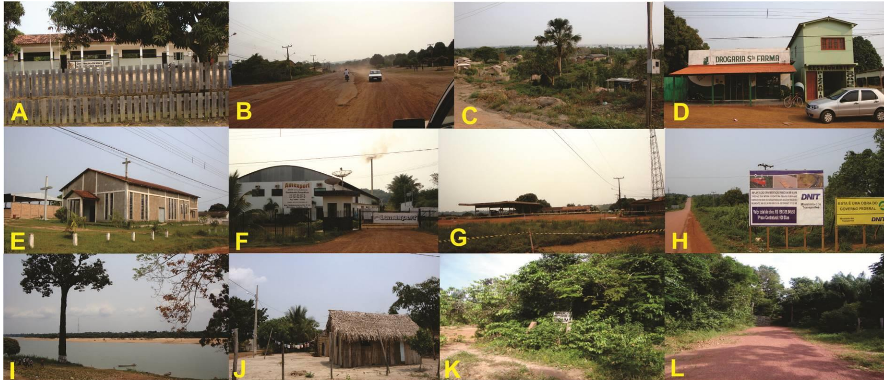
(A)EFM Carlos Sarmiento, ponto 82; (B) Palmeira/Bairro do INCRA,ponto 85; (C) Bairro Jardim do Éden, ponto 91; (D) Área de concentração comércio/Miritituba, ponto 97; (E) Igreja Nossa Senhora de Nazaré, ponto 96; (F) Madeireira Amexport e SMH, ponto 102; (G) Posto de combustível/Auto Posto Ouro Mil, ponto 118; (H) BR 163,ponto 117; (I) Praia Paranaimirim/Itaverão, ponto 125; (J) Comunidade Paranaimirim, ponto 128; (K)Confinante da área do empreendimento/CAIMA,ponto 132; (L) Entrada à área do empreendimento,ponto 135.
