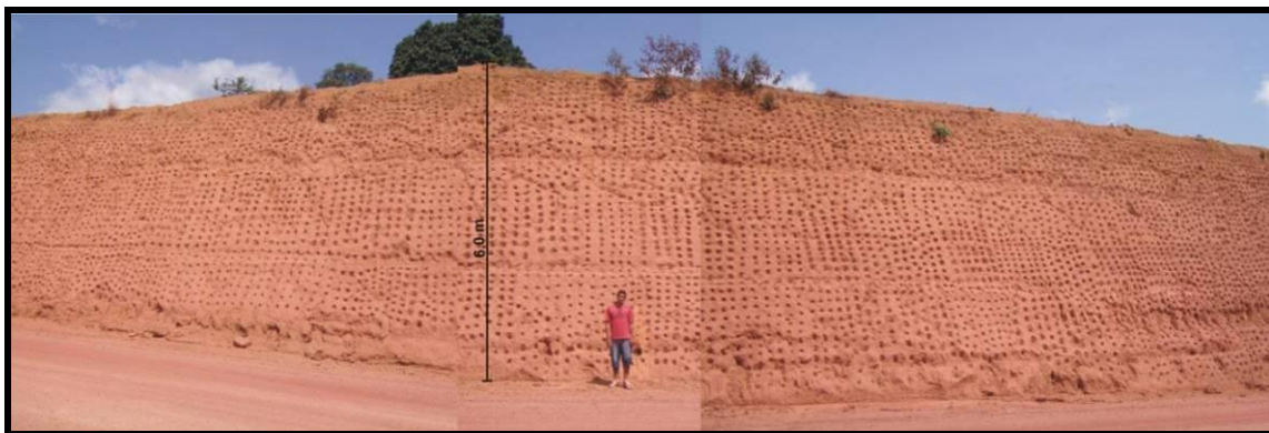
FOTO 4.2-17: Argissolo vermelho-amarelo, em corte de estrada, com cerca de 6 metros de altura.
