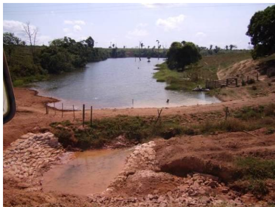
FOTO 4.2-28: Açude formado em vale associado à planície de inundação.
