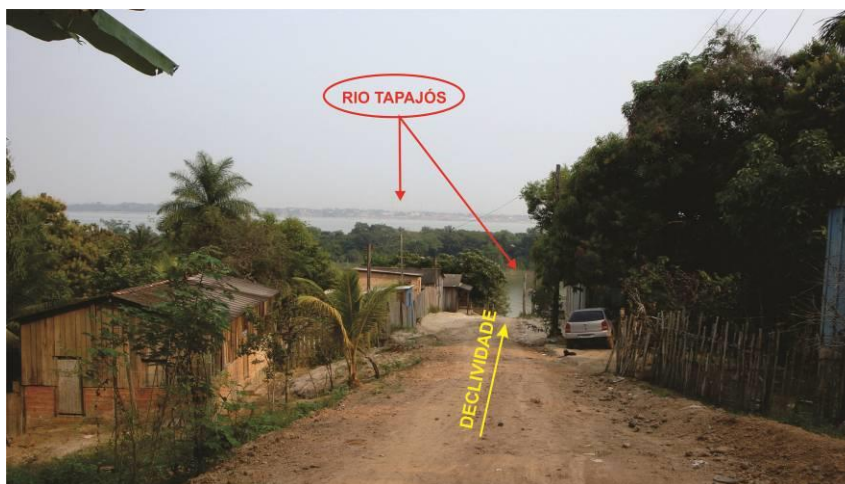
Figura 4.4-9 – Residências de Miritituba em área sujeita a alagamento
