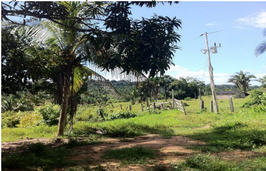
Figura 7.3.22 - Presença de rede de energia elétrica.
