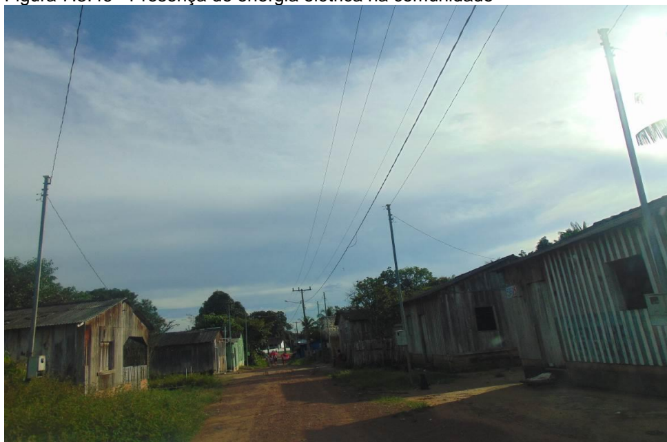
Figura 7.3.46 - Presença de energia elétrica na comunidade
