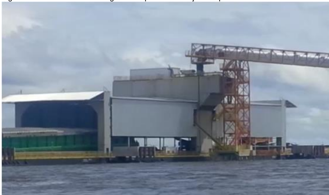
Figura 3.28 - Estrutura de carregamento que utiliza fixação em pinos.
