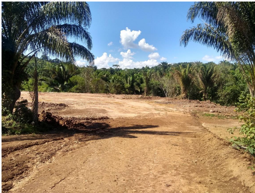
Figure 5.32 - Foto da área de bota fora. Área já utilizada para este fim nas obras de abertura da via de acesso.
