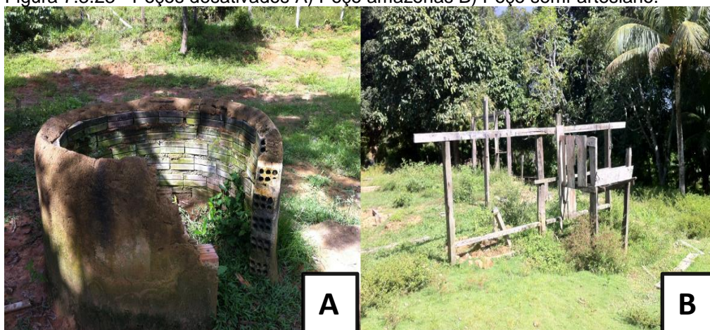
Figura 7.3.23 - Poços desativados A) Poço amazonas B) Poço semi-artesiano.
