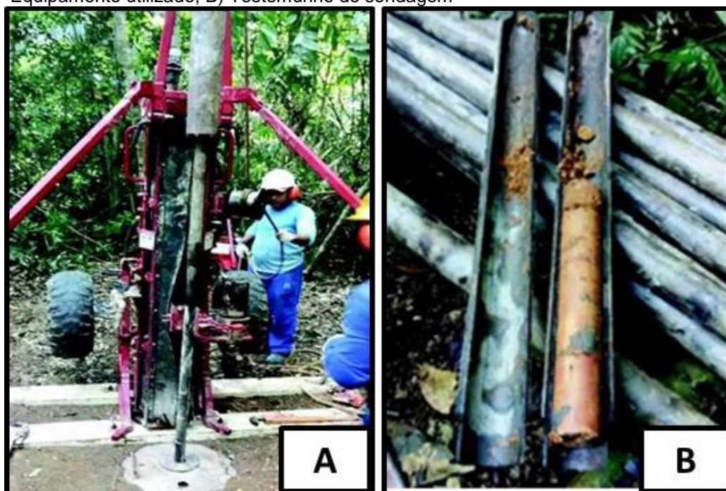
Figura 7.1.28 - Aspecto da sondagem rotativa e testemunho de sondagem. A) Equipamento utilizado; B) Testemunho de sondagem
