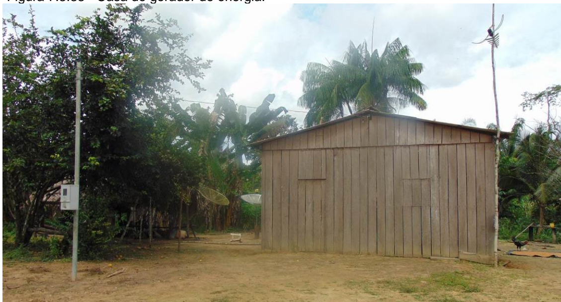
Figura 7.3.33 - Casa de gerador de energia.
