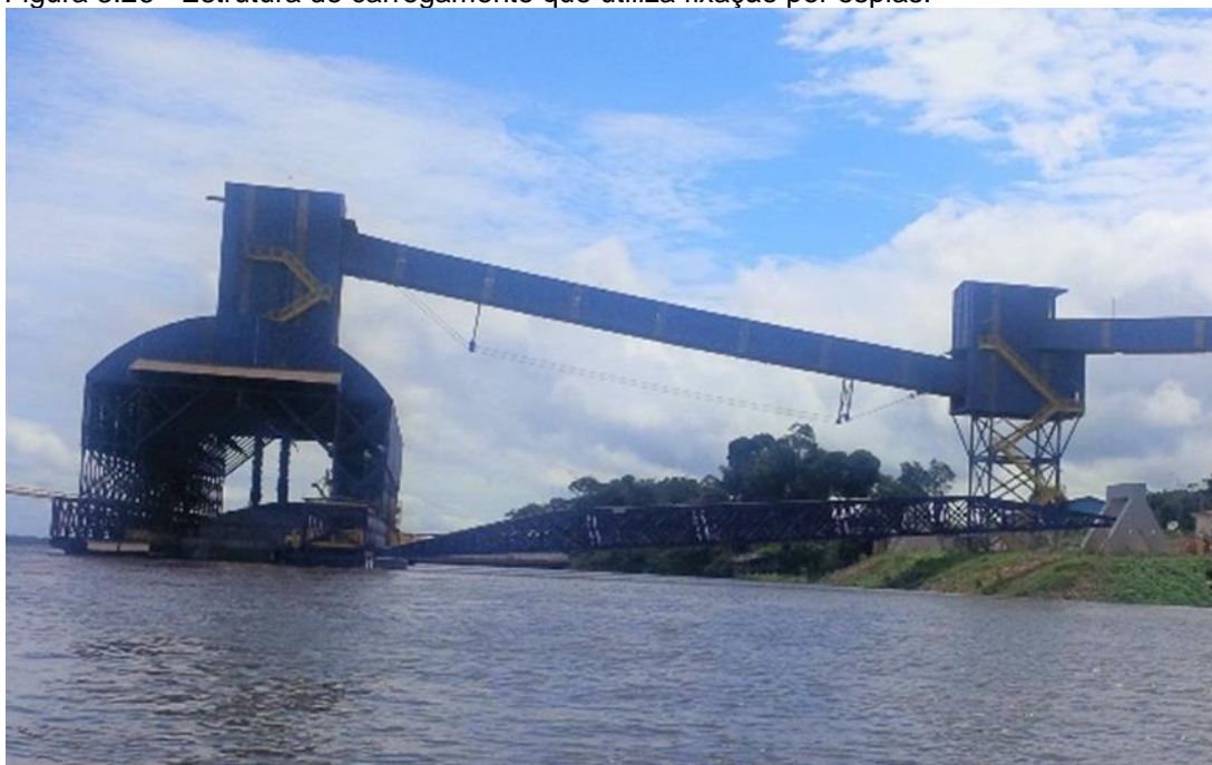
Figura 3.26 - Estrutura de carregamento que utiliza fixação por espias.
