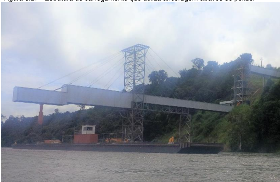
Figura 3.27 - Estrutura de carregamento que utiliza ancoragem através de poitas.
