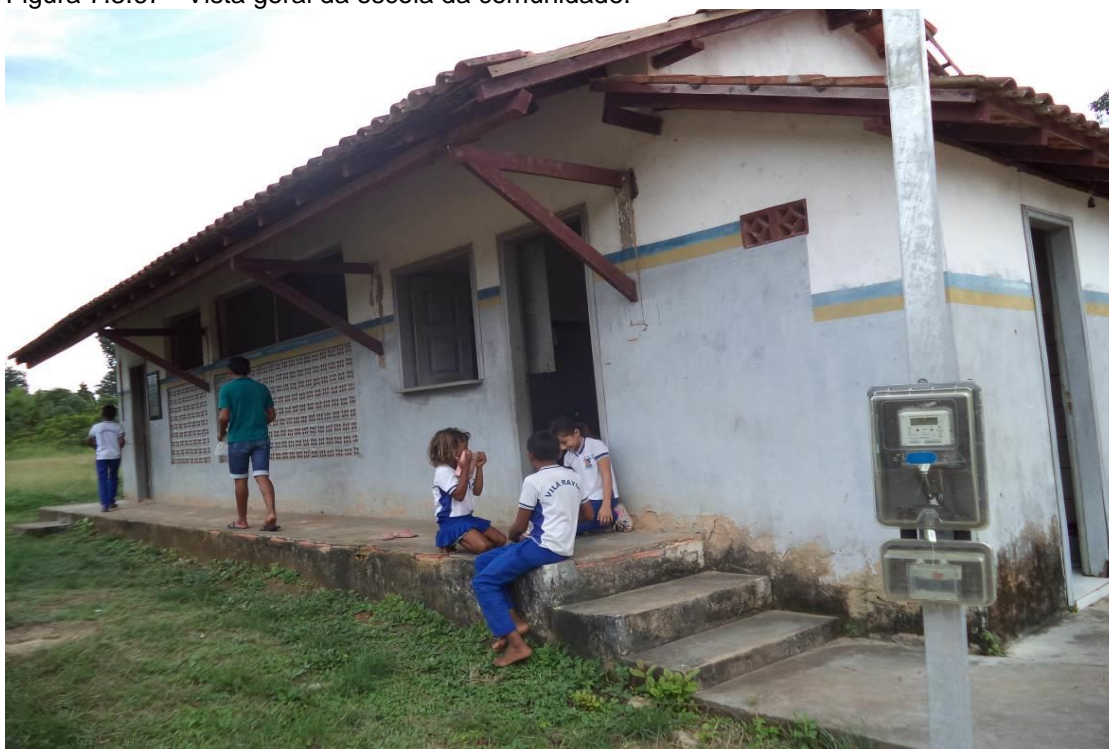
Figura 7.3.67 - Vista geral da escola da comunidade.
