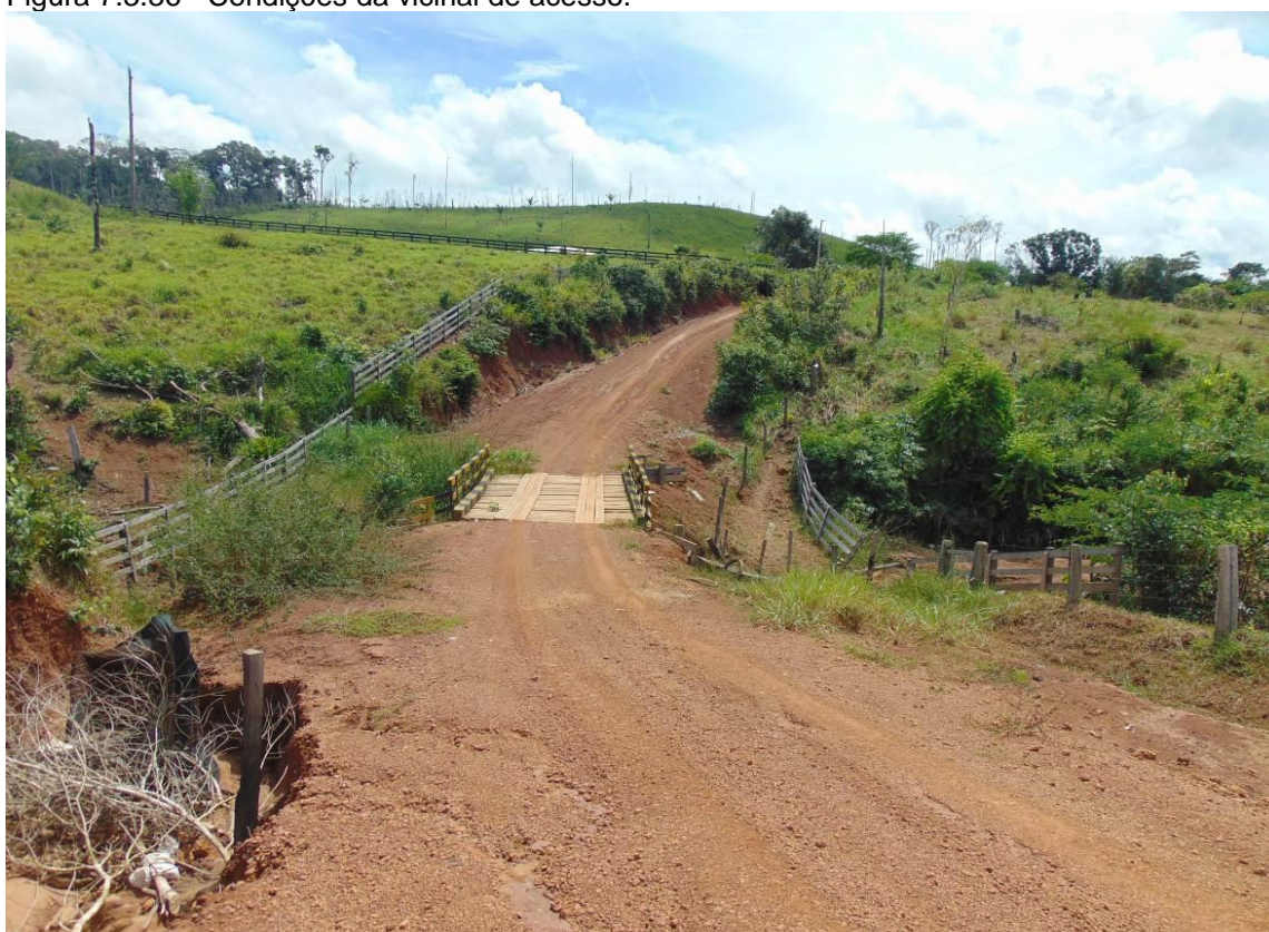
Figura 7.3.36 - Condições da vicinal de acesso.
