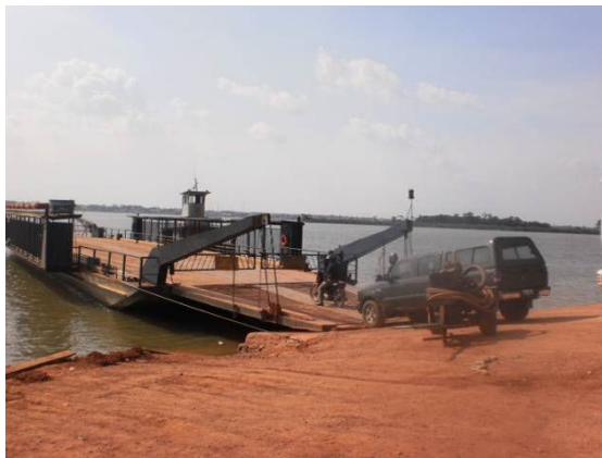
Balsa para travessia de Miritituba para Itaituba.
