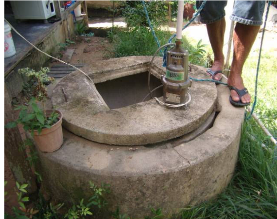
Poço amazonas (P1). Fonte: EIA / RIMA ETC Terfron, 2010.
