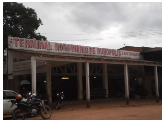
Terminal Rodoviário de Rurópolis.
