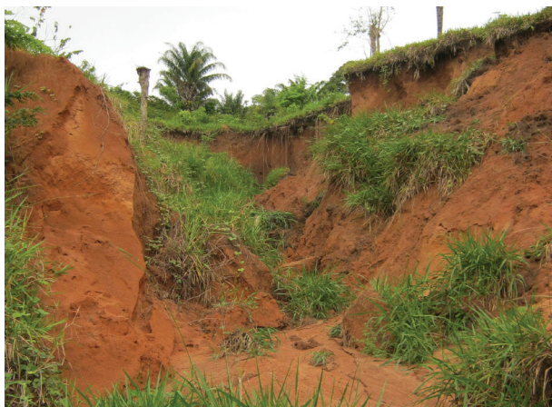
Voçoroca na área de influência do empreendimento
