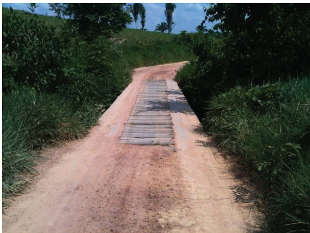
Estrada Vicinal Km 30, acesso à futura ETC Santarenzinho.
