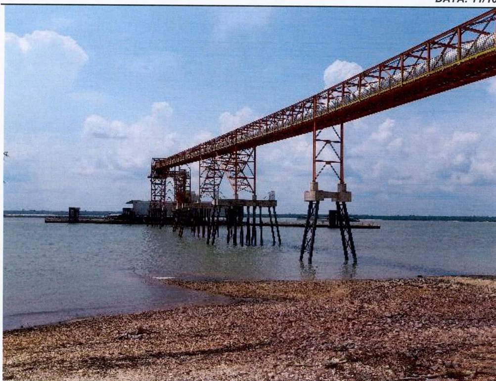
Figura 14 – Pier e correia transportadora
