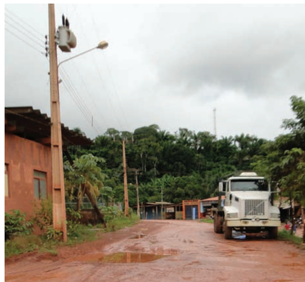
Condições das vias de acesso em Miritituba.
