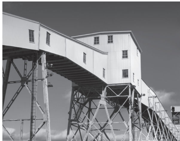
Exemplo de sistema de correias transportadoras enclausurado
