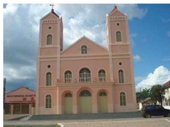
Figura 56. Igreja Nossa Senhora de Sant’ana. Itaituba.
