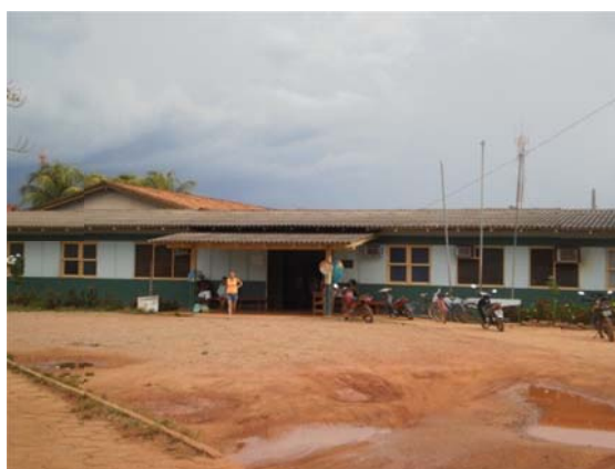
Figura 145. Hospital Municipal em Rurópolis. Outubro/2011.
