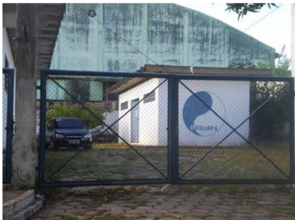
Figura 69. COSANPA – Companhia de Saneamento do Pará. Maio/2012.
