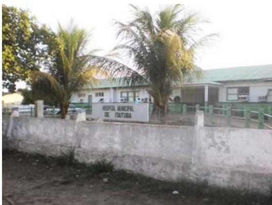
Figura 136. Hospital Municipal de Itaituba. Maio/2012.
