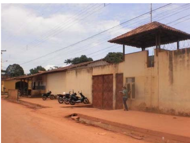
Figura 146. Unidade Prisional de Itaituba. Maio/2012.
