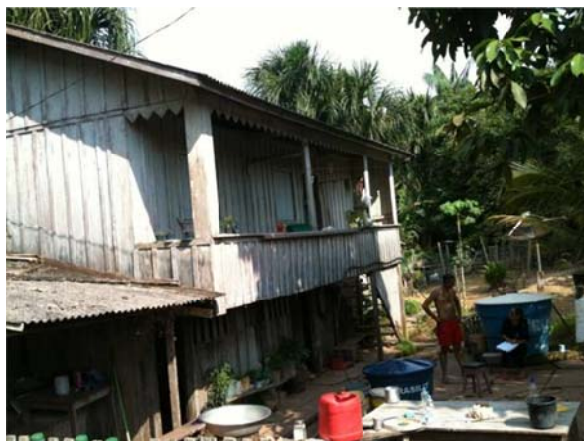
Figura 179. Asbel Anério – Vicinal Km 30. Itaituba/PA. Outubro/2012.
