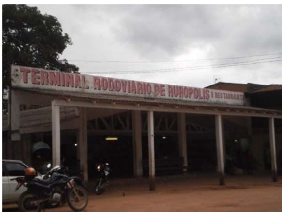
Figura 89. Terminal Rodoviário de Rurópolis. Outubro/2011.
