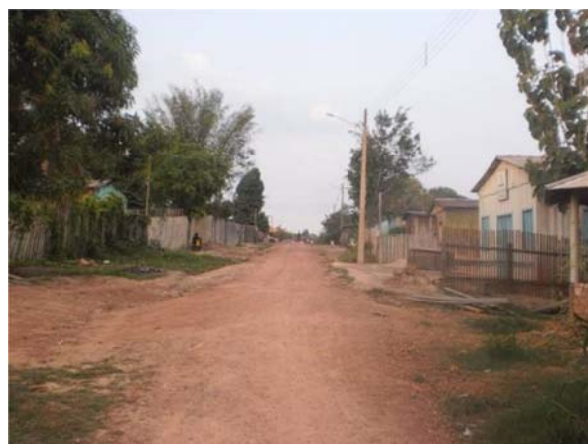
Figura 111. Ruas com falta de pavimentação em Miritituba. Outubro/2012.
