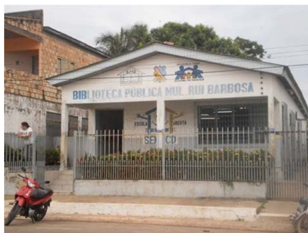
Figura 41. Biblioteca Pública de Itaituba. Maio/2012.
