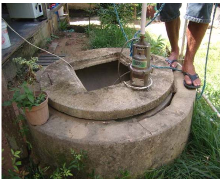
Figura 40. Poço amazonas (P1). Fonte: EIA / RIMA ETC Terfron, 2010.
