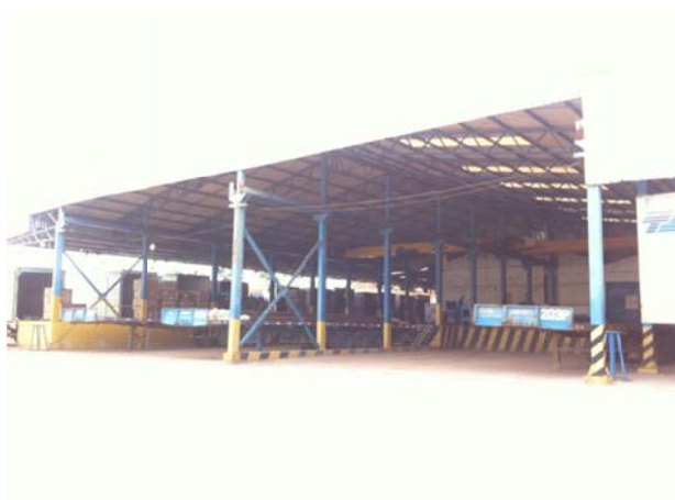
Figura 13. Galpão para carregamento e descarregamento de cargas gerais.
