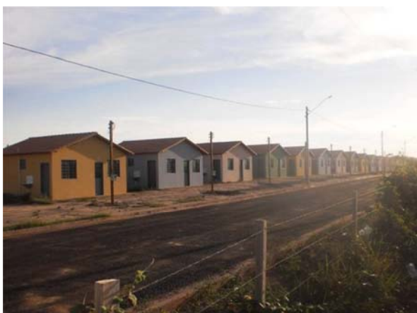
Figura 108. Conjunto Habitacional de Itaituba. Outubro/2012.
