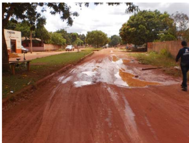
Figura 114. Avenida em Rurópolis. Outubro/2012.
