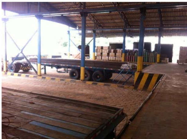
Figura 15. Piso elevado para carregamento e descarregamento de cargas.
