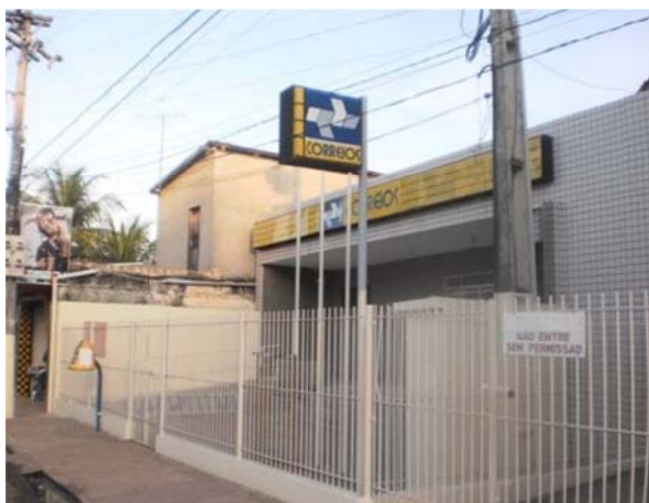
Figura 98. Sede de correios em Itaituba. Maio/2012.
