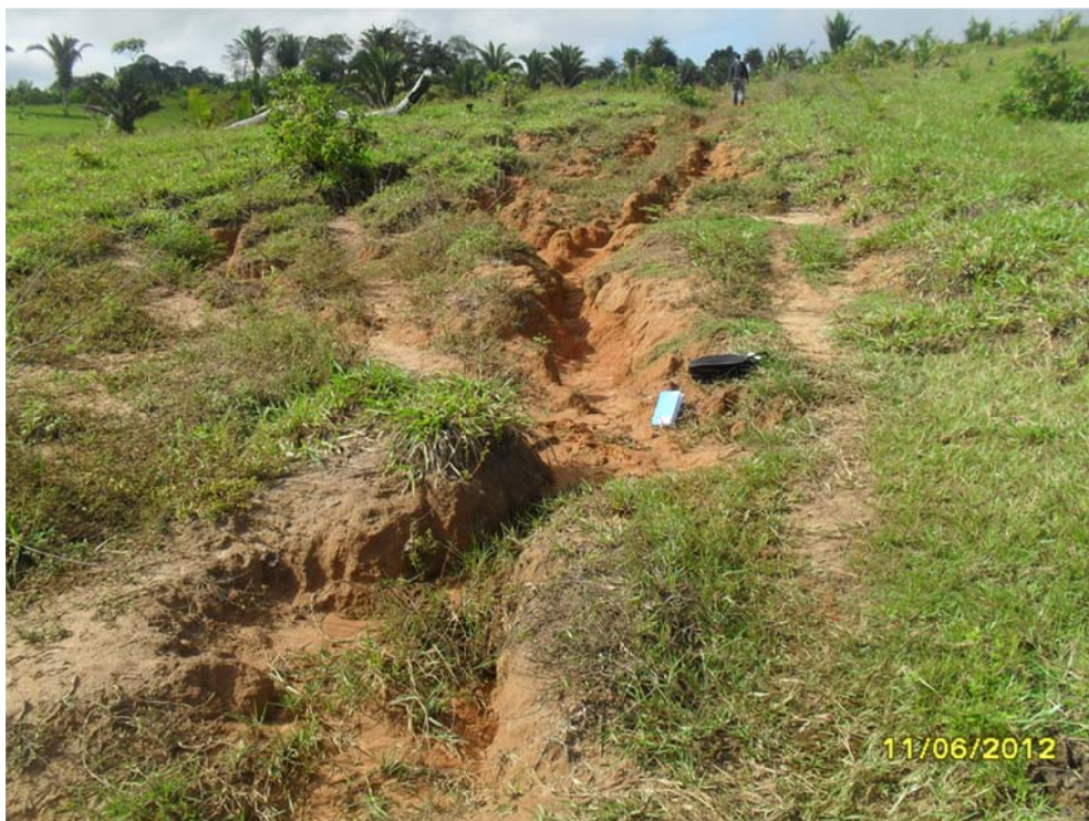
Figura 23. Aspecto de processo erosivo que se desenvolve em terrenos do Planalto Residual do Tapajós em áreas marginais da BR-364 margem esquerda do rio Tapajós.
