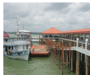
Figura 39 - Terminal Hidroviário de Itaituba.
