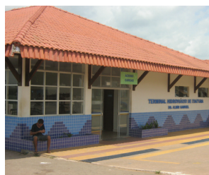
Figura 38 - Terminal Hidroviário de Itaituba.
