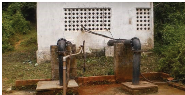
Figura 40- Captação de água em Rurópolis.
