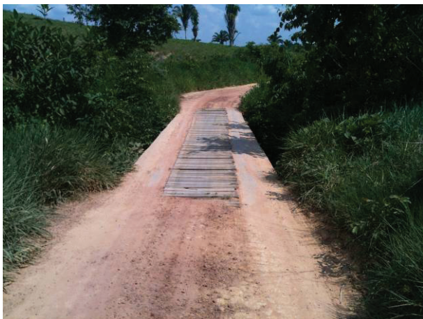
Estrada Vicinal Km 30, acesso à futura ETC Rurópolis.
