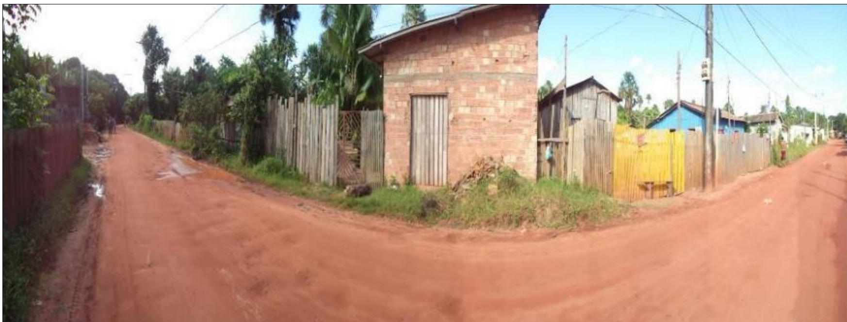
Figura 46 - Padrão Construtivo das moradias localizadas no entorno do empreendimento.
