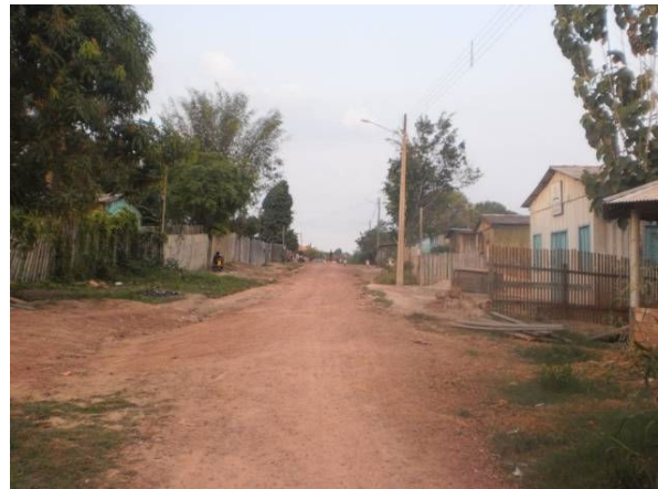
Figura 112. Ruas com falta de pavimentação em Miritituba.
