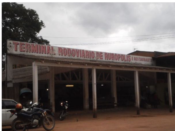
Figura 89. Terminal Rodoviário de Rurópolis.
