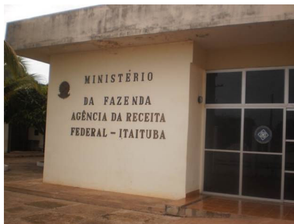
Figura 66. Ministério da Fazenda – Agência da Receita Federal de Itaituba.
