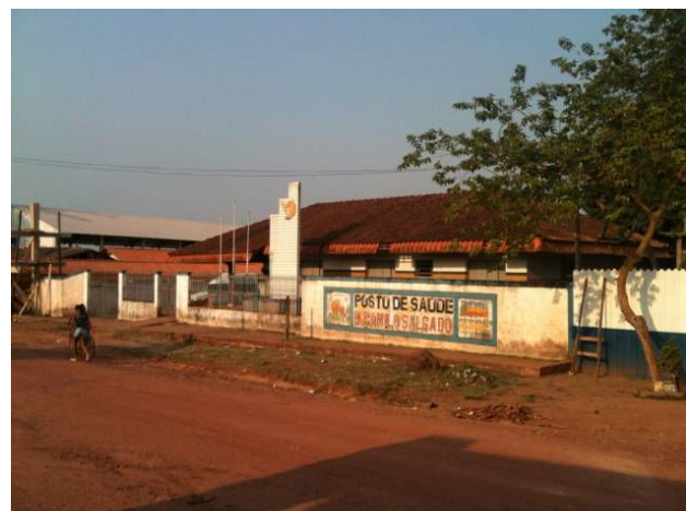
Figura 140. Unidade de Saúde desativada no Km 30. Itaituba.
