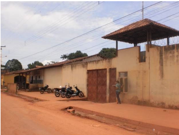
Figura 147. Unidade Prisional de Itaituba.
