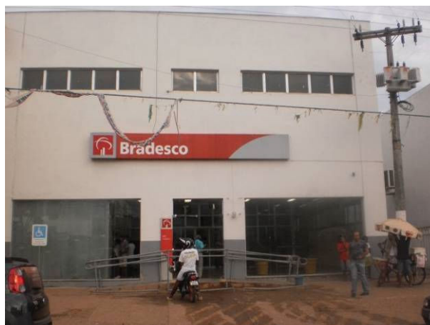
Figura 68. Agência Bancária – Bradesco em Itaituba.
