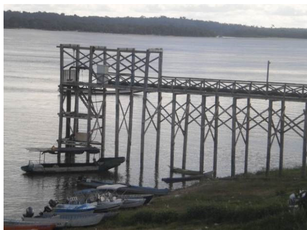
Figura 70. Rio Tapajós, local de captação de Água em Itaituba.
