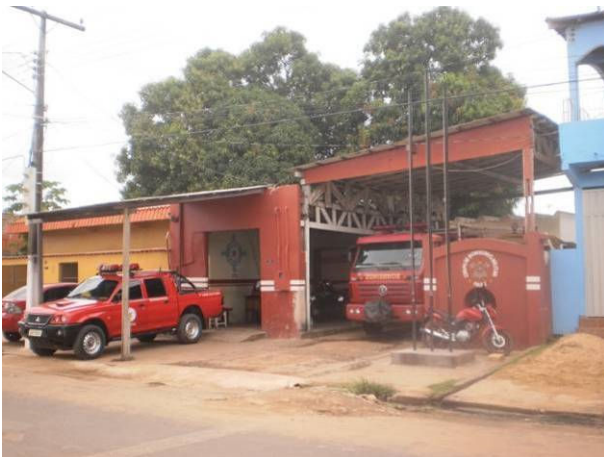
Figura 149. Unidade do Corpo de Bombeiros de Itaituba.
