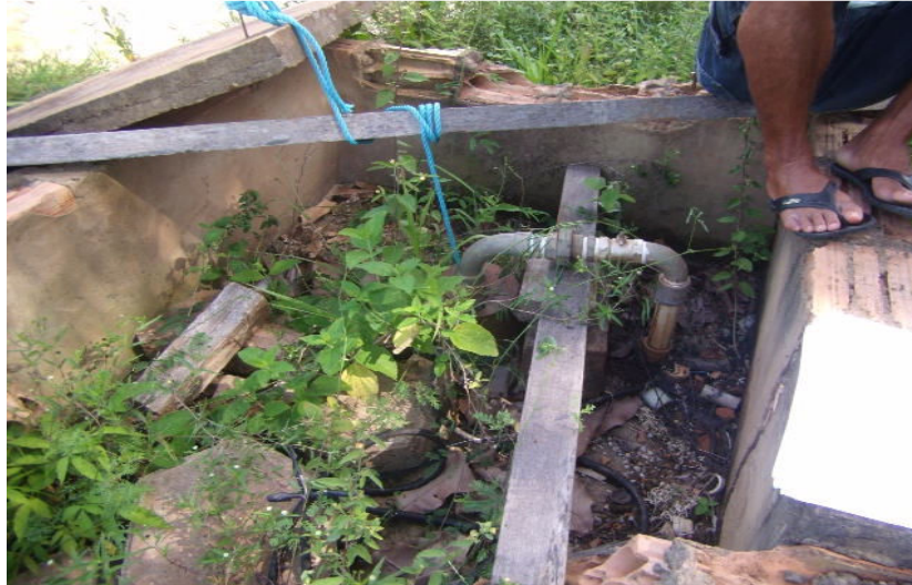
Figura 39. Poço tubular da Unirios (P3). Fonte: EIA / RIMA ETC Terfron, 2010.
