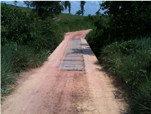
Figura 93. Estrada e pontes na Estrada Vicinal Km 30.
