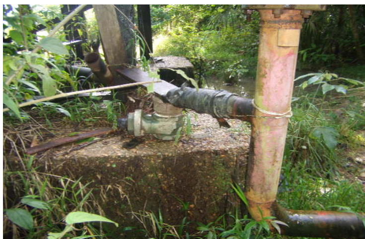
Figura 37. Poço tubular da Petrobrás (P2). Fonte: EIA / RIMA ETC Terfron, 2010.
