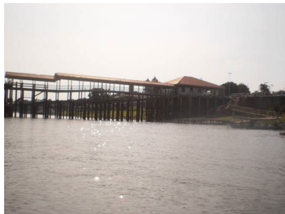
Figura 84. Terminal Hidroviário, Itaituba.
