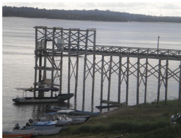
Figura 158: Rio Tapajós, local de captação de Água em Itaituba. Outubro/2011.
