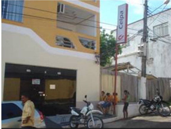
Figura 154: CELPA / REDE energia.
