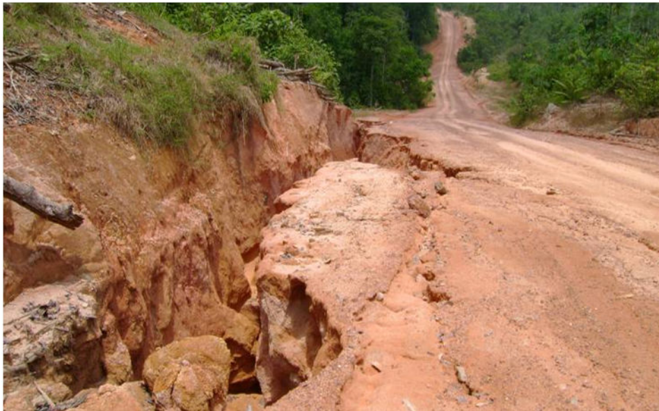
Figura 28: Aspecto de processos erosivos registrados no Planalto Residual Tapajós em trecho da rodovia BR 230 – Transamazônica, próximo ao Igarapé Missão, município de Itaituba. Fonte: CNEC, 2008.
