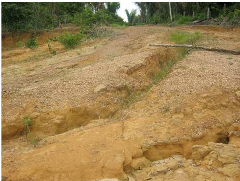
Figura 37: Terreno argiloso e desnudo desenvolvendo processo erosivo de relativa intensidade no interior da ADA em decorrência da chuvas concentradas.
