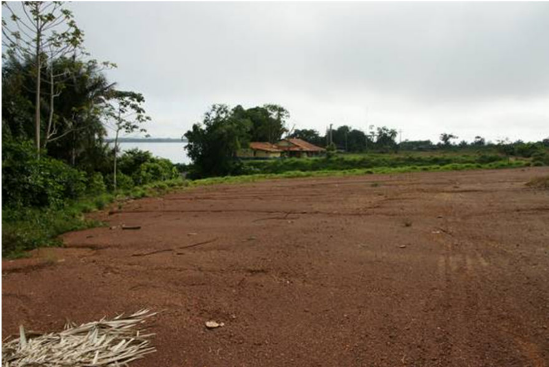
Figura 31: Vista parcial da área onde será erguida a ETC, que está assentada sobre o Pediplano Pleistocênico, localmente terraceado; ao fundo o rio Tapajós tem seu encaixamento referenciado à retomada de erosão holocênica.
