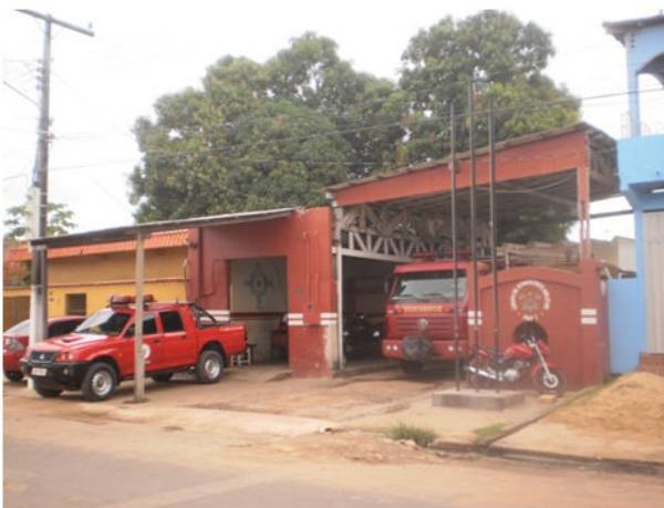
Unidade do Corpo de Bombeiros de Itaituba. Outubro/2011.
