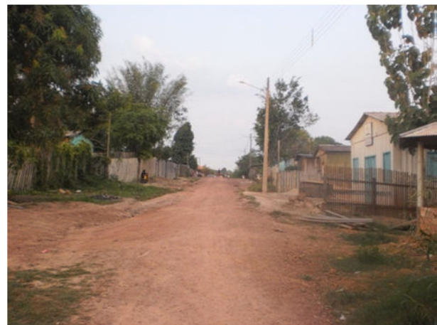
Ruas com falta de pavimentação em Miritituba.
