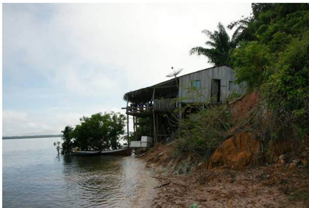
Figura 36: Aspecto dos barrancos marginais ao rio Tapajós nas proximidades da ADA do empreendimento.
