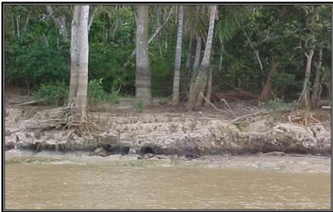
Figura 64 – Nota-se o nível d'água marcado nas árvores (marca escura), aproximadamente 5m. Observa-se também a erosão acentuada expondo as raízes das árvores na Ilha do Ituqui.
