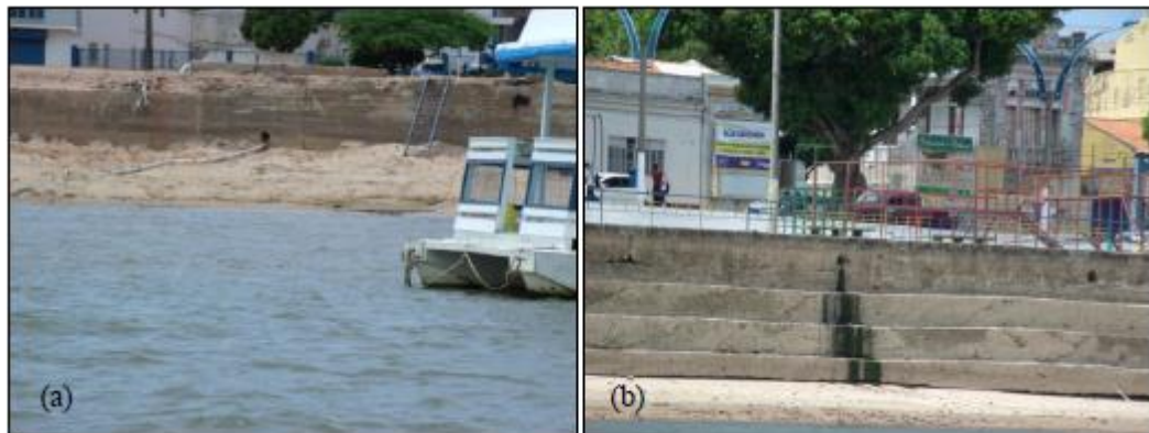
Figura 92: Lançamento de esgoto ao longo da orla da cidade de Santarém: a) próximo ao ponto 5 e, b) próximo ao ponto 3.
