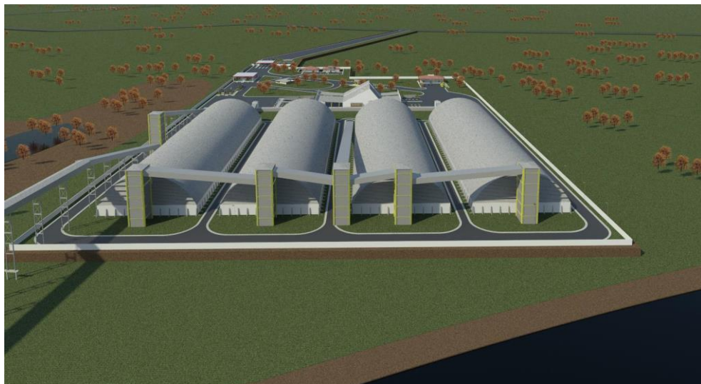
Figura 17- Vista das torres, armazéns e esteiras transportadoras
