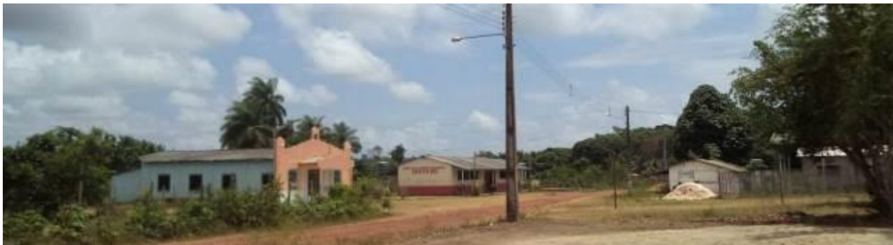
Figura 252: Vista parcial da área central da Comunidade Cristo Rei, Santarém-PA.
