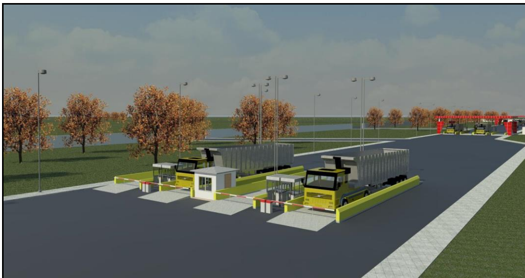
Figura 8: Balanças rodoviárias na entrada do terminal
