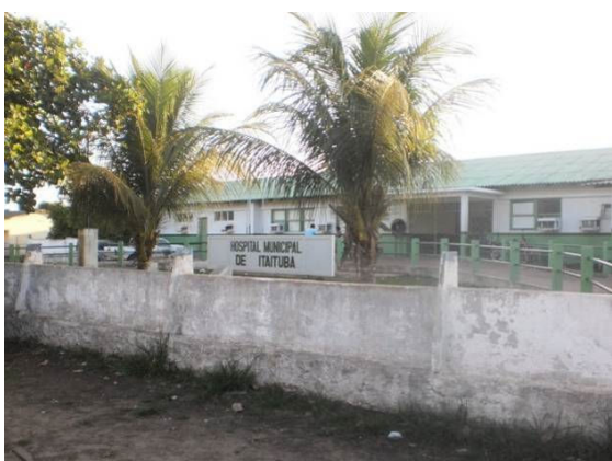
Figura 363. Hospital Municipal de Itaituba. Maio/2012.
