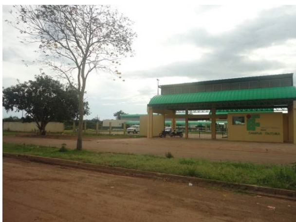
Figura 351. Figura 22: Instituto Federal do Pará. Itaituba/PA. Maio/2012.
