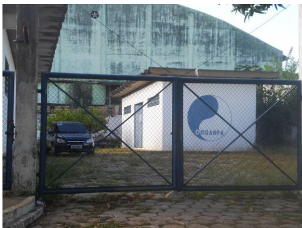
Figura 296. COSANPA – Companhia de Saneamento do Pará. Maio/2012.
