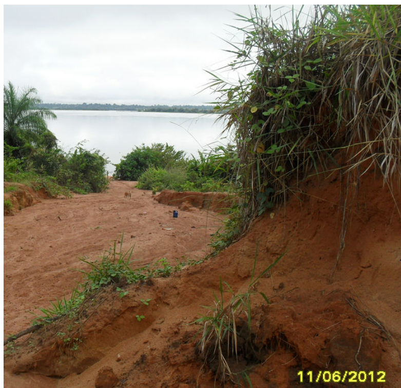
Figura 17. Aspectos da camada sedimentar aluvionar de grande espessura situada na margem esquerda do rio Tapajós no local de acesso à ETC Tapajós.
