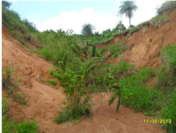
Figura 19. Aspecto de voçoroca formada em terreno arenoso da Cobertura Superficial Cenozoica constituída por depósito aluvionar holocênico à margem do rio Tapajós na ADA da ETC Tapajós.
