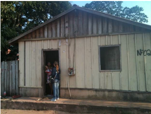
Figura 339. Residências no Povoado Campo Verde (Km 30), Itaituba. Outubro/2012.
