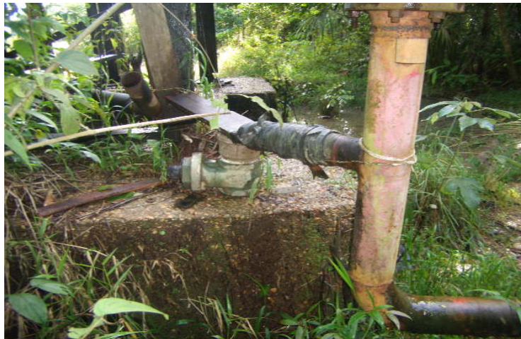
Figura 39. Poço tubular da Petrobrás (P2). Fonte: EIA / RIMA ETC Terfron, 2010.
