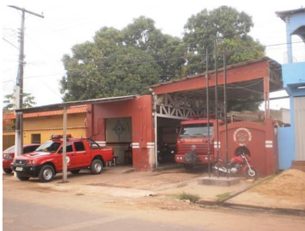
Figura 375. Unidade do Corpo de Bombeiros de Itaituba. Maio/2012.
