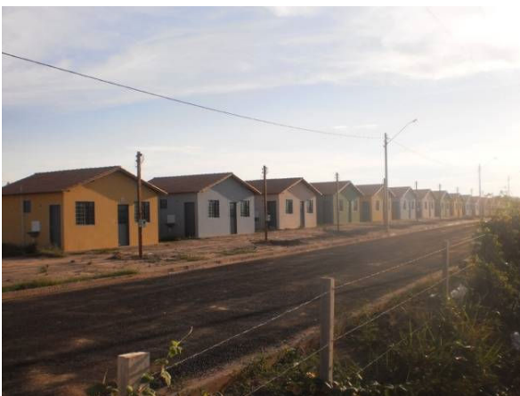
Figura 335. Conjunto Habitacional de Itaituba. Outubro/2012.
