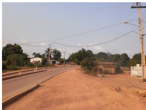
Figura 314. Entrada de Miritituba via rodovia Transamazônica. Maio/2012.
