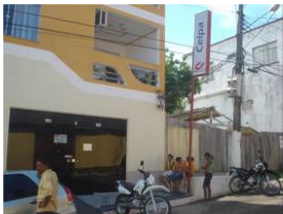
Figura 333. CELPA / REDE energia.
