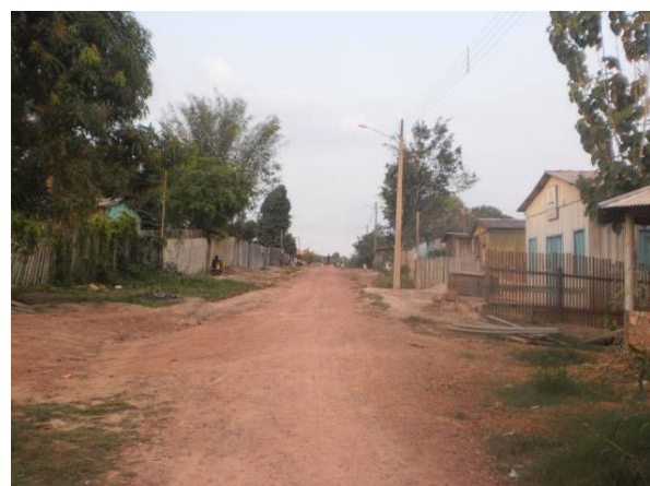
Figura 338. Ruas com falta de pavimentação em Miritituba. Outubro/2012.
