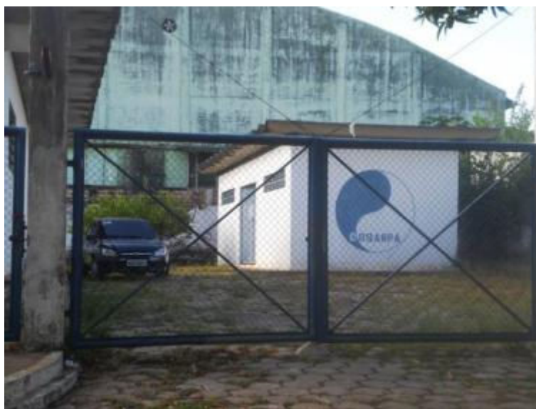
Companhia de Saneamento do Pará.
