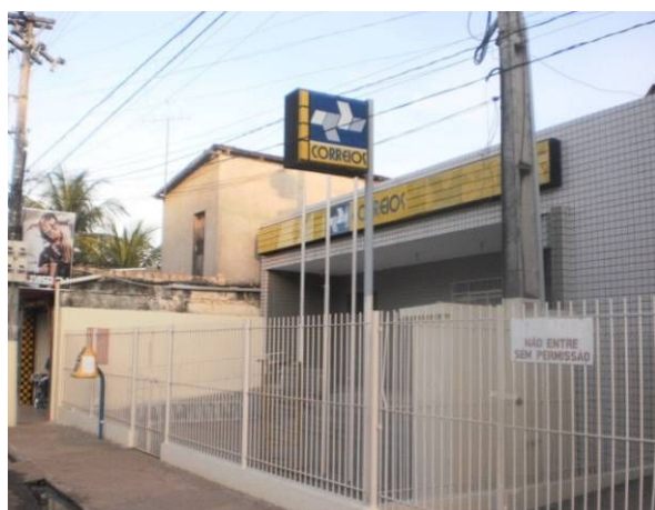
Figura 191. Sede de correios em Itaituba. Maio/2012.
