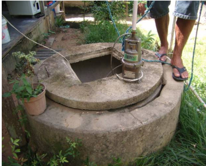
Figura 31. Poço amazonas (P1). Fonte: BRANDT, 2011.
