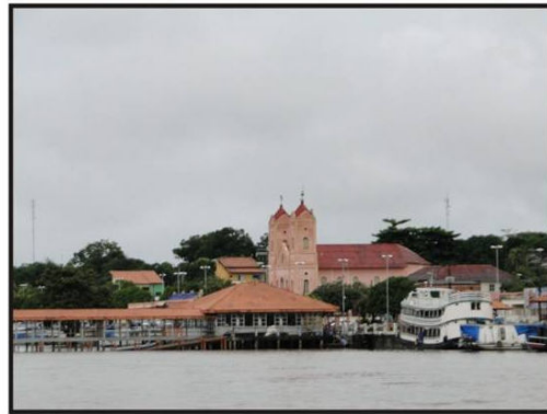
VISTA DO PIER DE ITAITUBA – RIO TAPAJÓS
