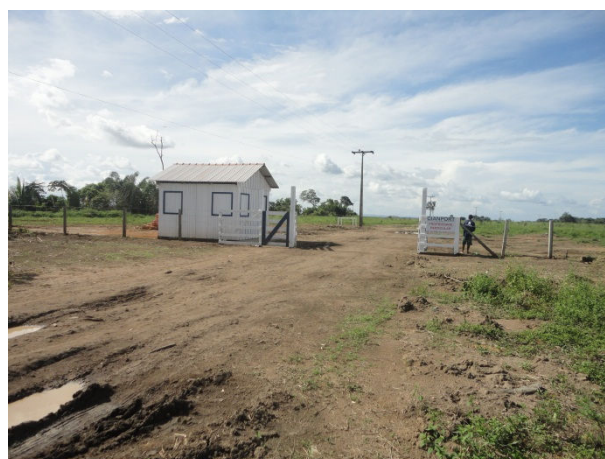
Figura 144. Área de instalação da ETC ITAITUBA. Maio/2012.
