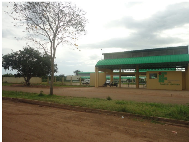
Figura 158. Instituto Federal do Pará. Itaituba/PA. Maio/2012.
