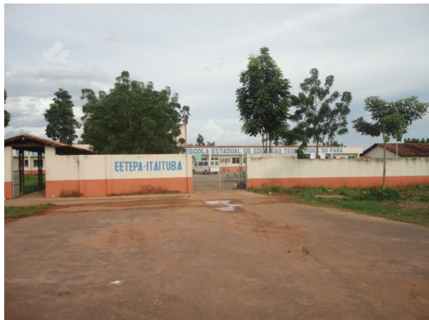
Figura 157. Escola Estadual de Educação Tecnológica do Pará. Itaituba/PA. Maio/2012.
