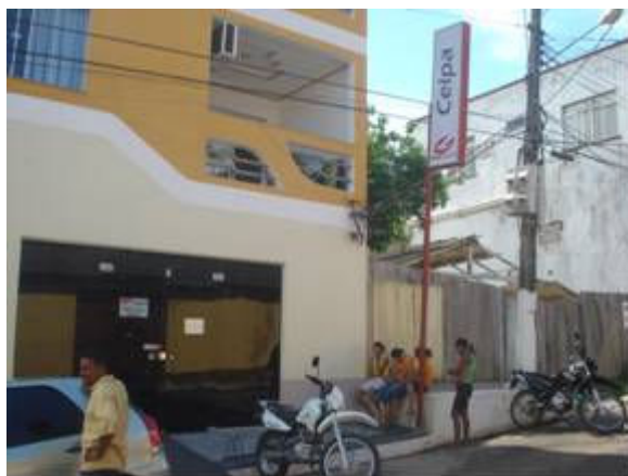
Figura 187. CELPA / REDE energia.
