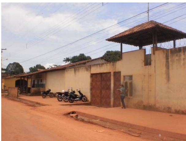
Figura 168. Unidade Prisional de Itaituba. Maio/2012.
