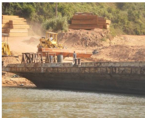
Figura 183. Terminal Portuário para escoamento de madeiras. Itaituba. Maio/2012.
