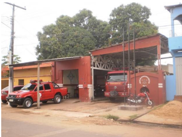
Figura 170. Unidade do Corpo de Bombeiros de Itaituba. Maio/2012.
