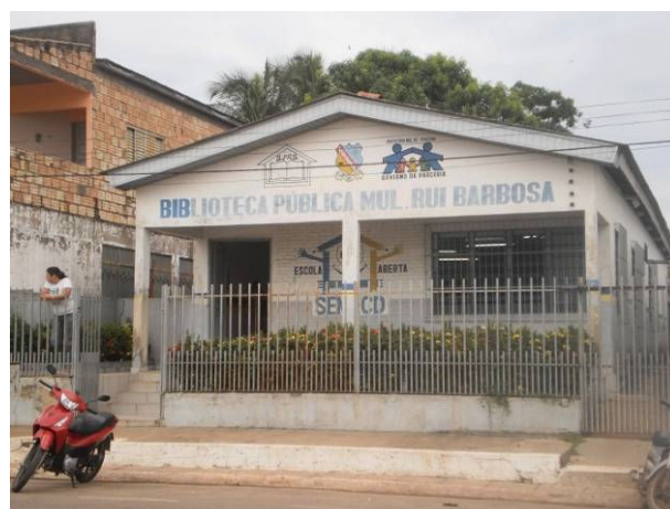
Figura 279. Biblioteca Pública de Itaituba. Maio/2012.
