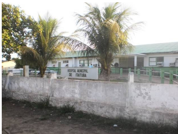
Figura 163. Hospital Municipal de Itaituba. Maio/2012.
