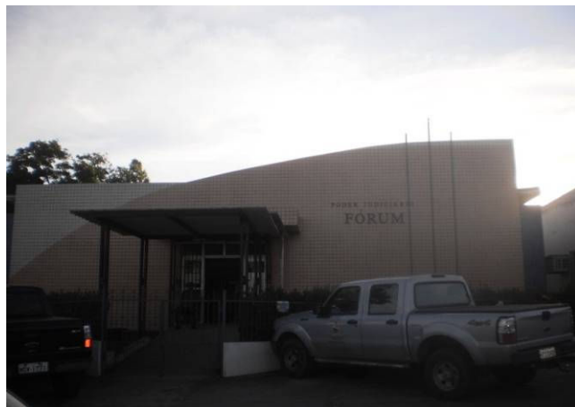
Figura 167. FÓRUM de Itaituba. Maio/2012.
