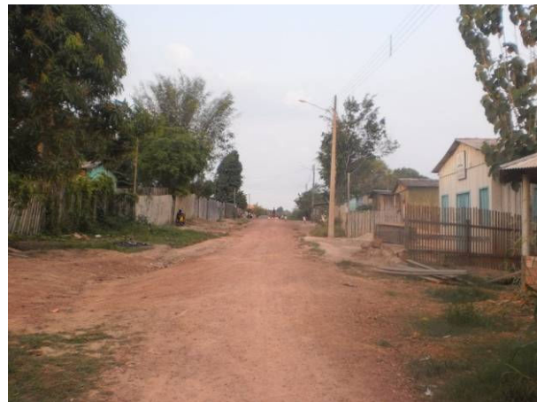
Figura 150. Ruas com falta de pavimentação em Miritituba. Maio/2012.
