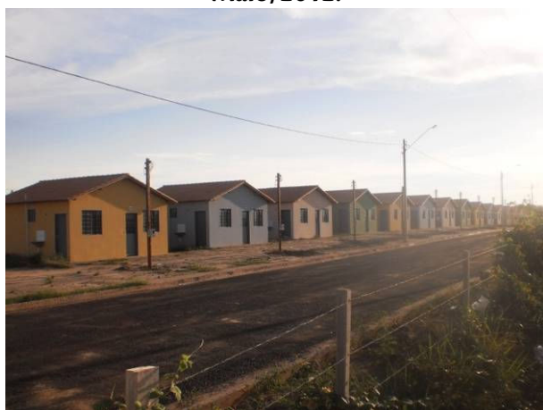
Figura 147. Conjunto Habitacional de Itaituba. Maio/2012.
